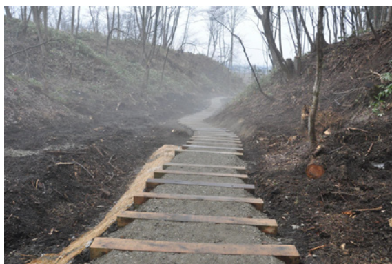
写真21 園路整備（第I期整備）
