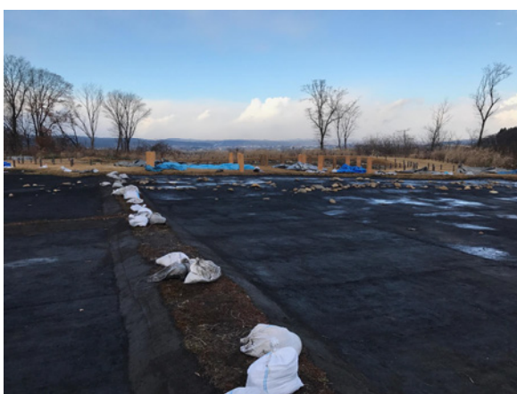
写真15 環状列石 C 擬土処理
