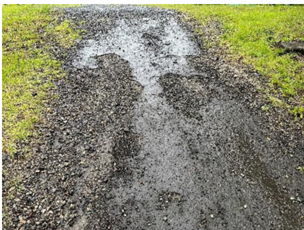
写真 23 管理用道路状況
