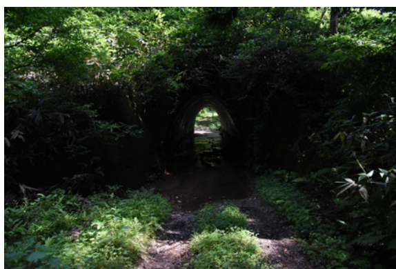
写真22 サービスルート予定地
